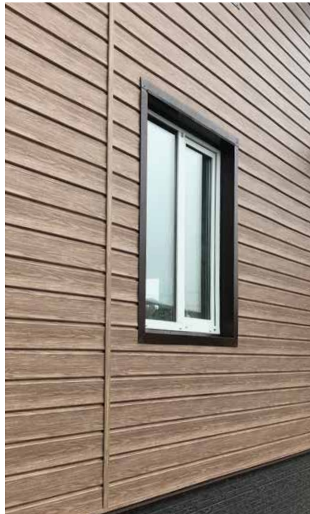
Пример монтажа сайдинга серии LUX под дерево
